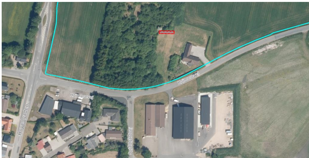
Luftfoto af del af ejendommen med skel (blå linje) og solceller markeret (rød skravering)
